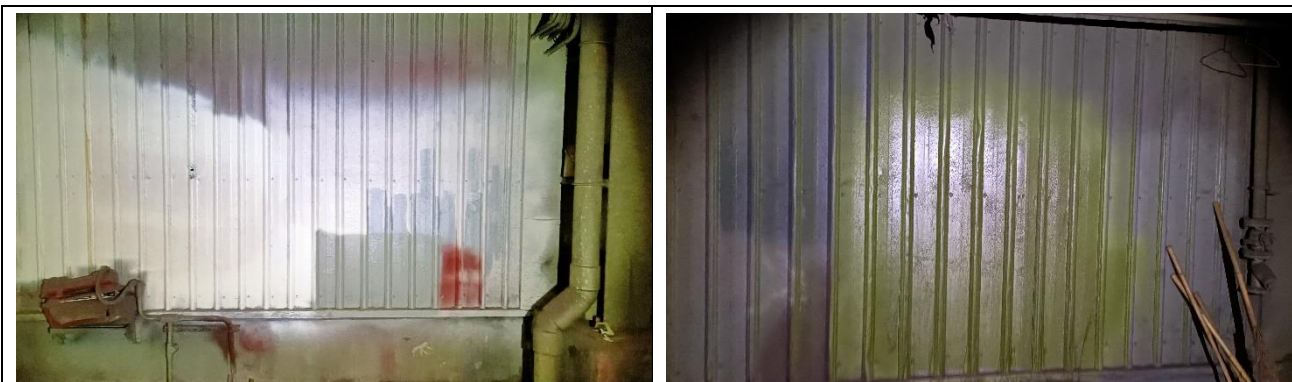
照片說明：將噴漆時剩餘之油漆噴塗在廠房鋼構表面，減少剩餘油漆固化量，亦可增加廠房結構防蝕能力，一舉兩得。
