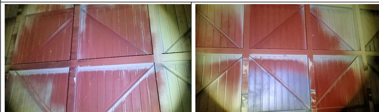
照片說明：將噴漆時剩餘之油漆噴塗在廠房大門表面，增加防蝕能力。
